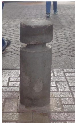
Imagen: Detalle de Bolardo de concreto armado
