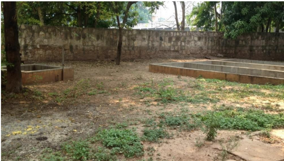
PILAS DE SECADO DE LA PLANTA DE TRATAMIENTO
