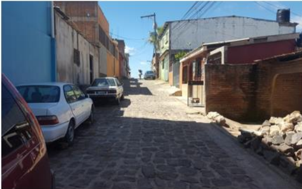
2. VISTA DE CALLE A PAVIMENTAR CON WHITE TOPPING
