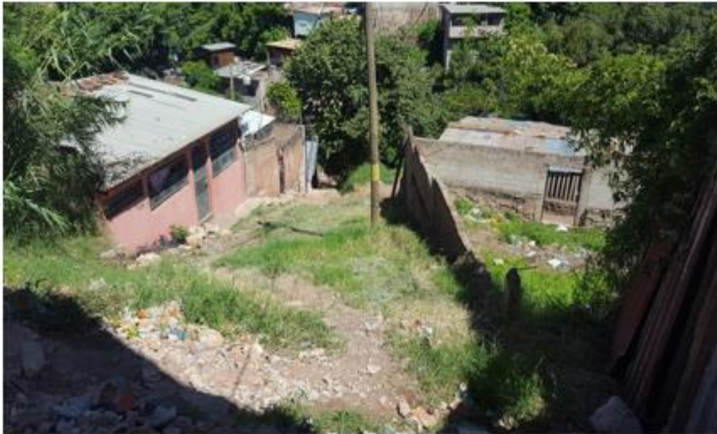
3. VISTA DE LUGAR DONDE SE CONSTRUIRAN GRADAS DE CONCRETO
