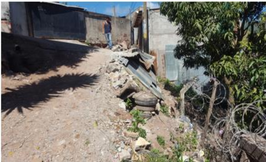
4. VISTA DONDE SE CONSTRUIRA MURO DE MAMPOSTERIA
