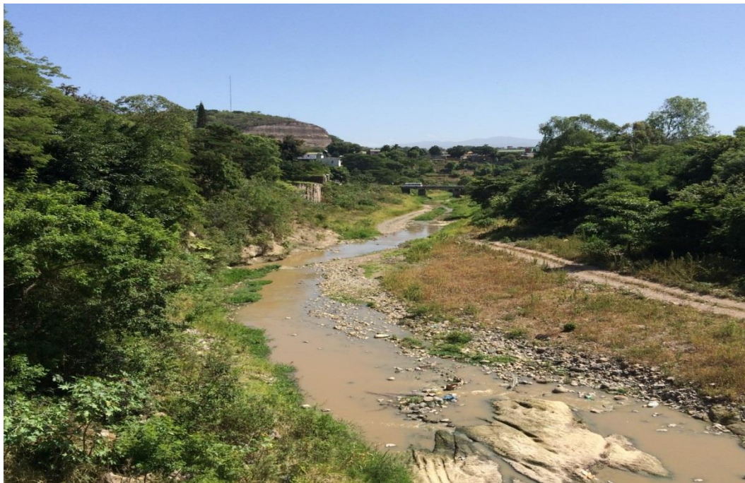
Vista del tramo a canalizar, colonia Loarque, vista aguas abajo
