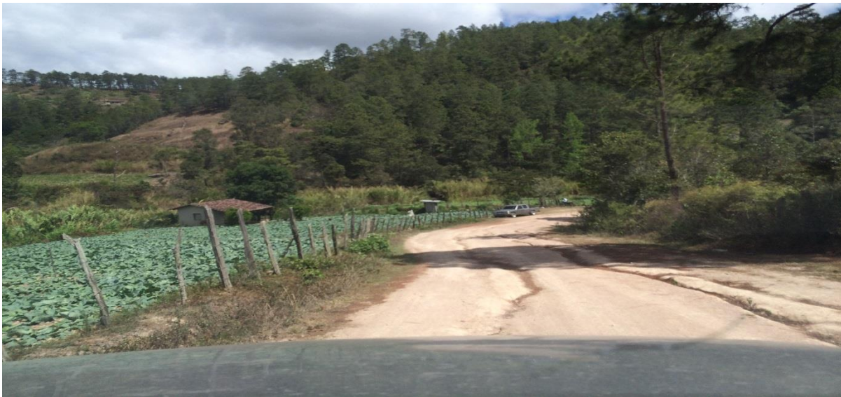
VISTA PANORAMICA DE CALLE A REPARAR
