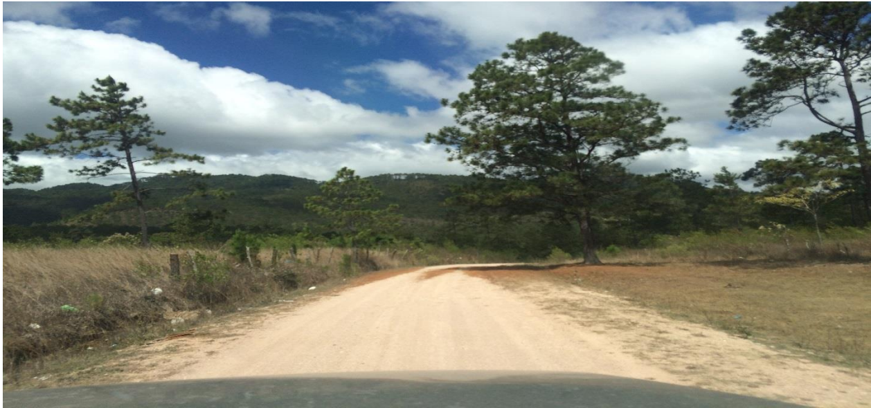
VISTA DE CALLE A REPARAR
