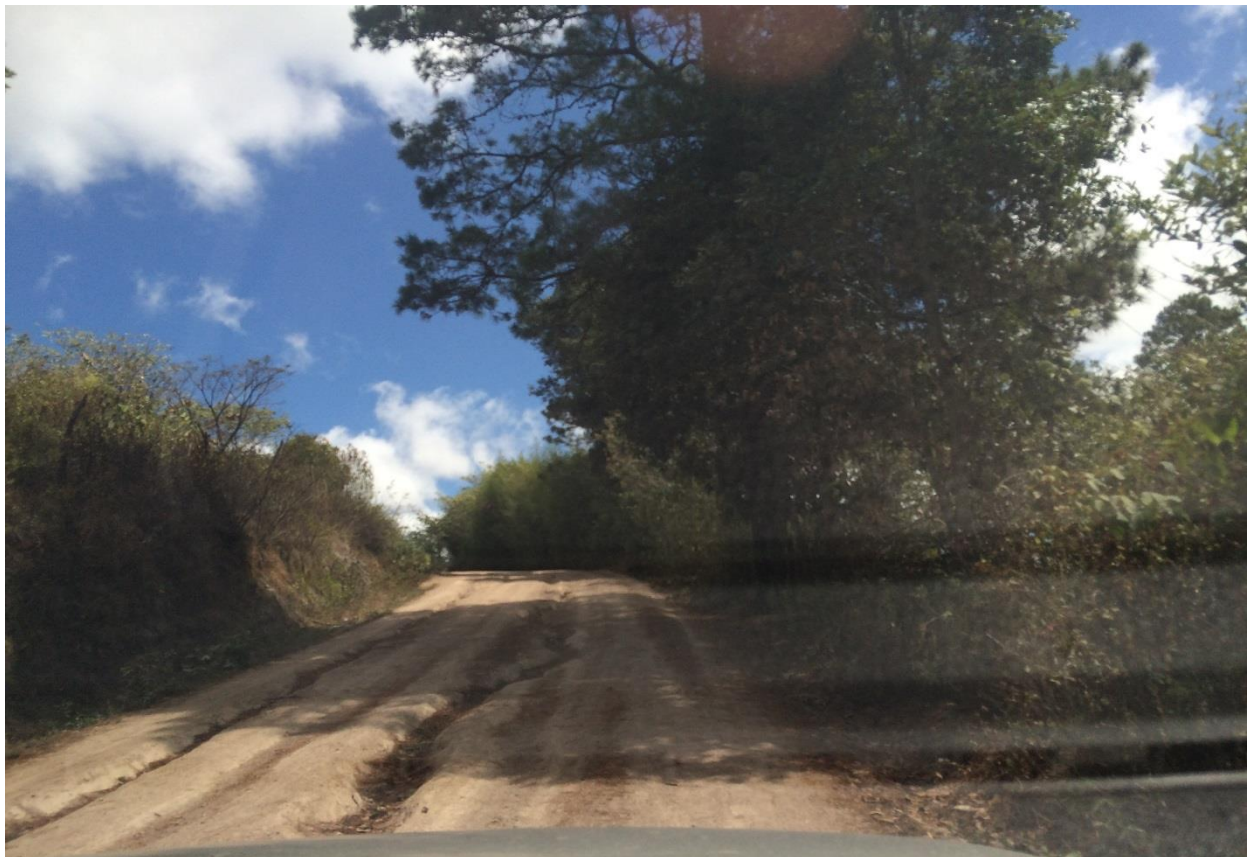
VISTA DE CALLE QUE REQUIERE BALASTADO
