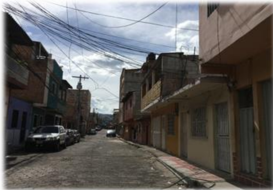
Final de pavimentación con concreto hidráulico
