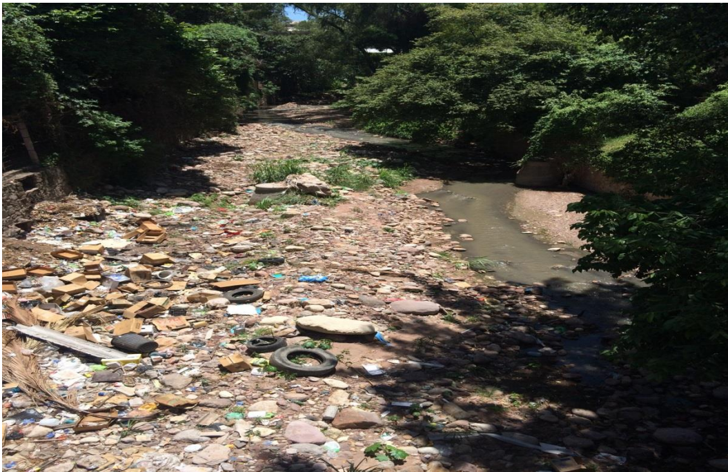
Vista del tramo con material acumulado
