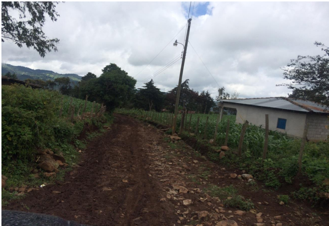
OTRA VISTA DE LA CALLE A REPARAR
