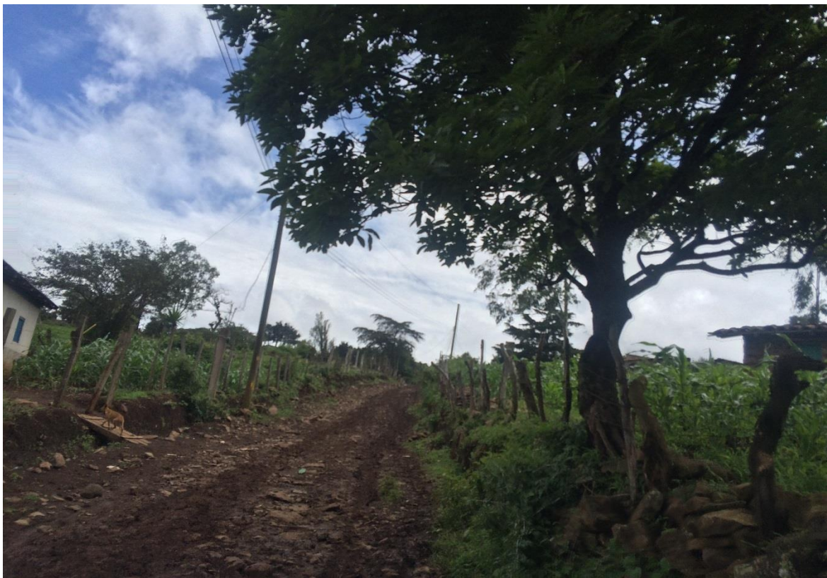
VISTA PANORAMICA DE LA CALLE A REPARAR: 1334
