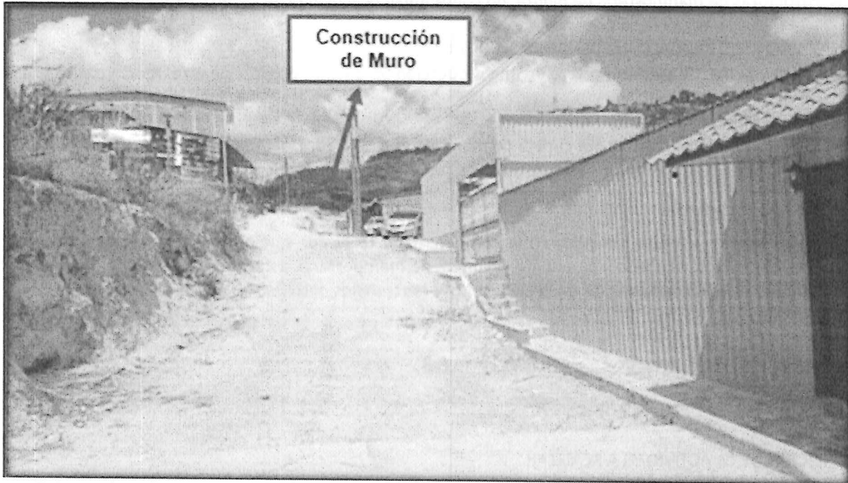
Tramo I de calle a pavimentar con concreto hidráulico y donde También se construirá muro de mampostería para protección de las viviendas y ampliar el ancho de la calzada
