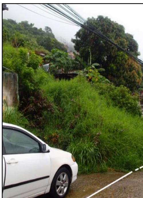
Ilustración 8. Material desplazado a causa del deslizamiento la que bloque una parte de la calle de la parte baja.
