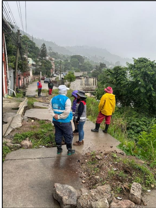
Ilustración 5. Imagen donde se aprecia la pérdida de la calle por el movimiento de tierra ocasionado por el deslizamiento.
