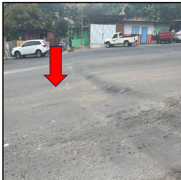
Ilustración 5. Subsistencia en la calzada
