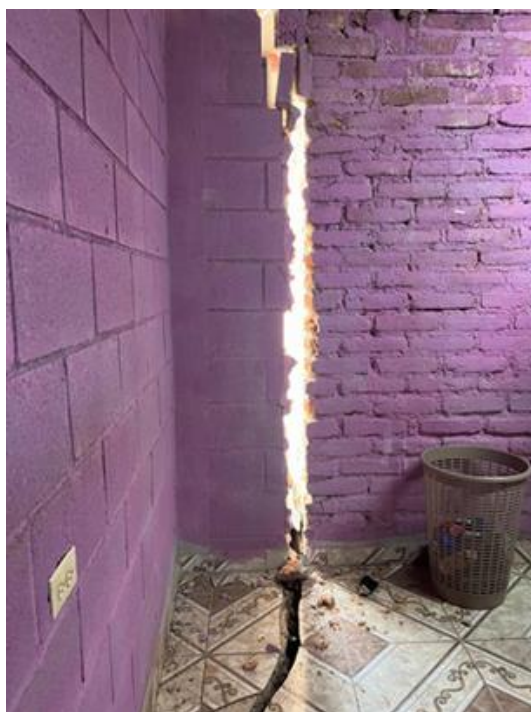
Ilustración 8. Grietas en la vivienda debido al movimiento del suelo.
