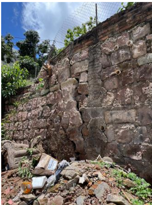
Ilustración 9. muros totalmente agrietados por el deslizamiento
