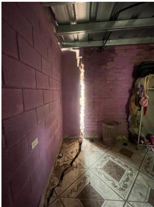
Ilustración 10. Grandes Grietas provocadas por el deslizamiento
