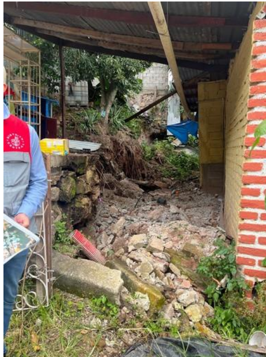
Ilustración 11. Escombros de paredes, muros de contención provocados por el movimiento de tierra.
