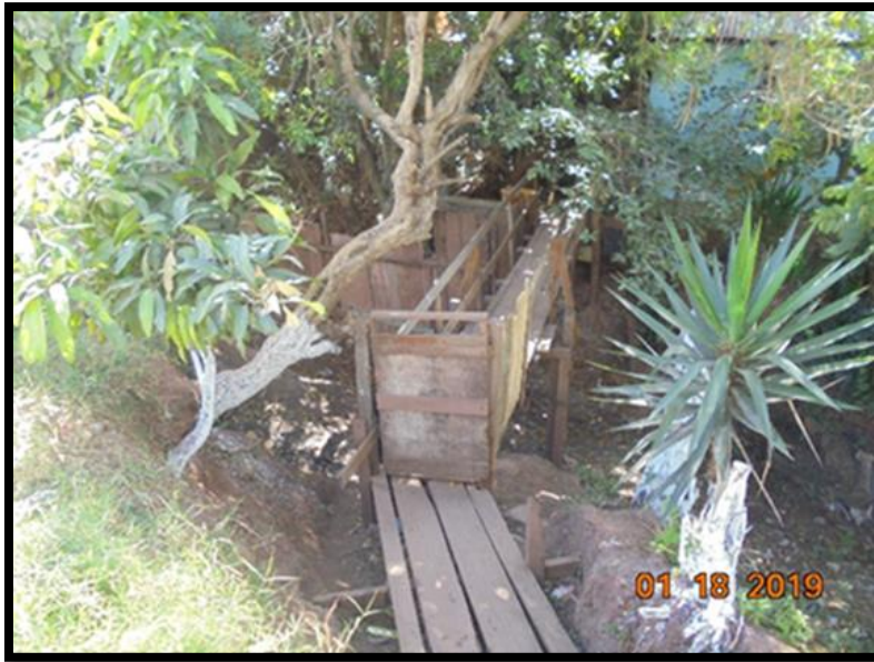
Ilustración 3 Puente de madera artesanal para acceso a vivienda sobre el cauce de la quebrada.
