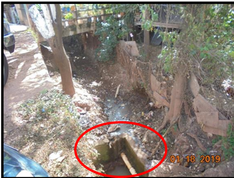
Ilustración 4 Acceso del flujo del cauce a obra de paso existente por debajo de la calle principal de la Colonia.
