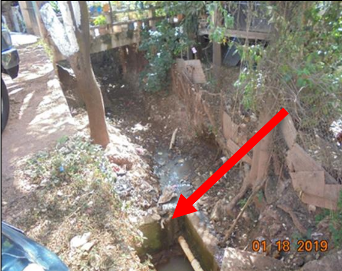
Ilustración 1. Acceso del flujo del cauce a obra de paso existente por debajo de la calle principal de la Colonia.
