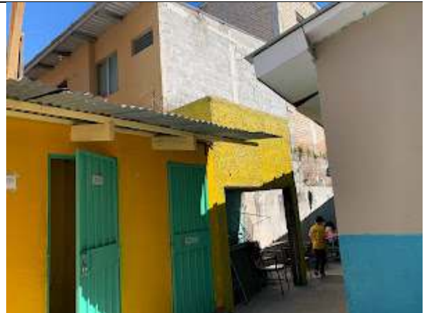
Ilustración 5: Módulo de sanitarios existente.
