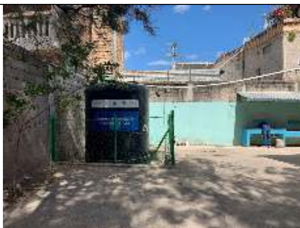
Ilustración 3: Tanque de almacenamiento existente.
