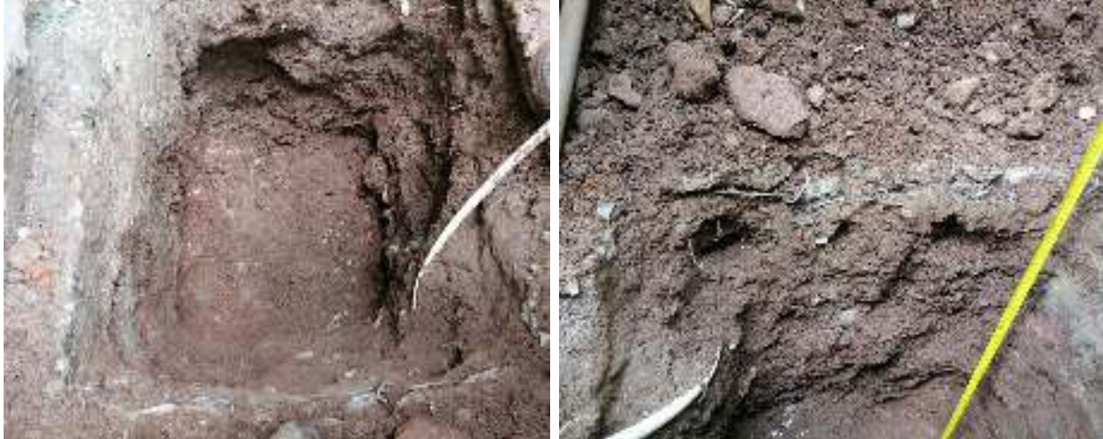
Figura 6 y 7: Excavación para la calicata
