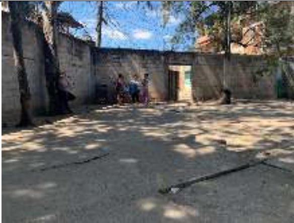
Ilustración 6: Patio sin drenaje.
