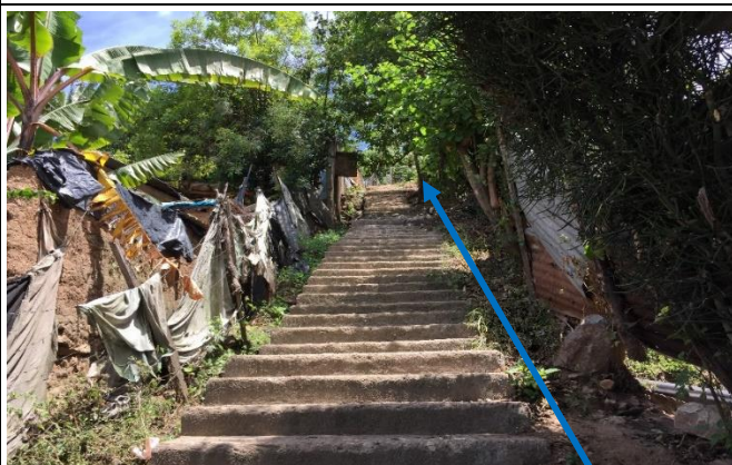
Ilustración 4. Segmento de gradas existente donde a un costado se construirá cunetas de 20 cm x 30 cm.
