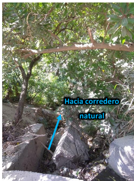
Fotografía 4 - Punto de descarga hacia corredero natural (incluir obra de disipación)
