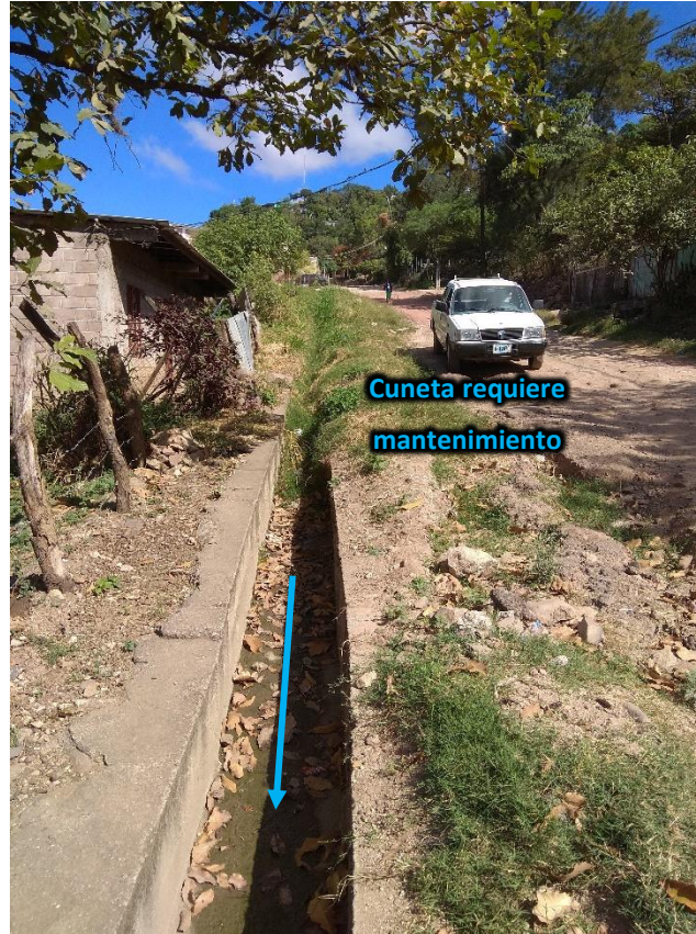
Fotografía 1 - Cuneta receptora (limpieza y readecuación)
