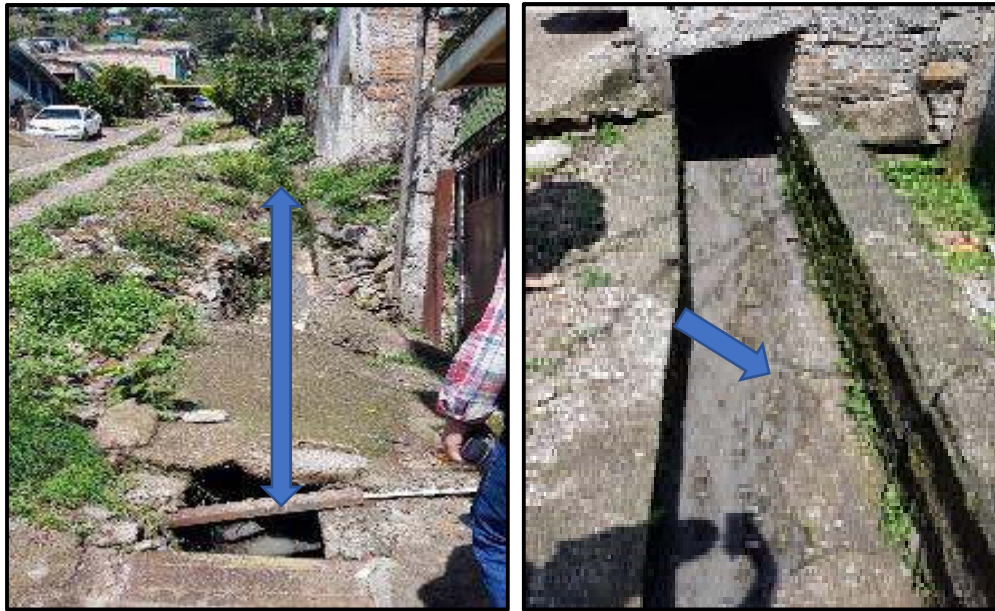
Ilustración 1. Tramo 1-2. Cuneta y losas de acceso de acceso a las viviendas existentes.
