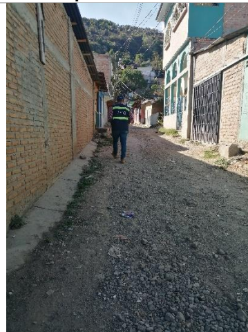
Ilustración 2. Se visualiza la falta de cunetas en el callejon (tramo C-D en el plano)
