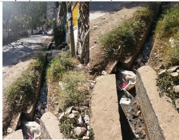
Ilustración 2. Se visualiza la falta de cunetas en el callejon (tramo C-D en el plano)
