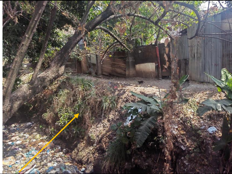
Imagen 1. Sitio de construcción de muro para protección de talud
