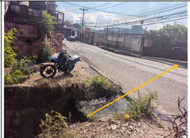
Imagen 4. Caja puente que será demolida y reconstruida con el área hidráulica requerida.
