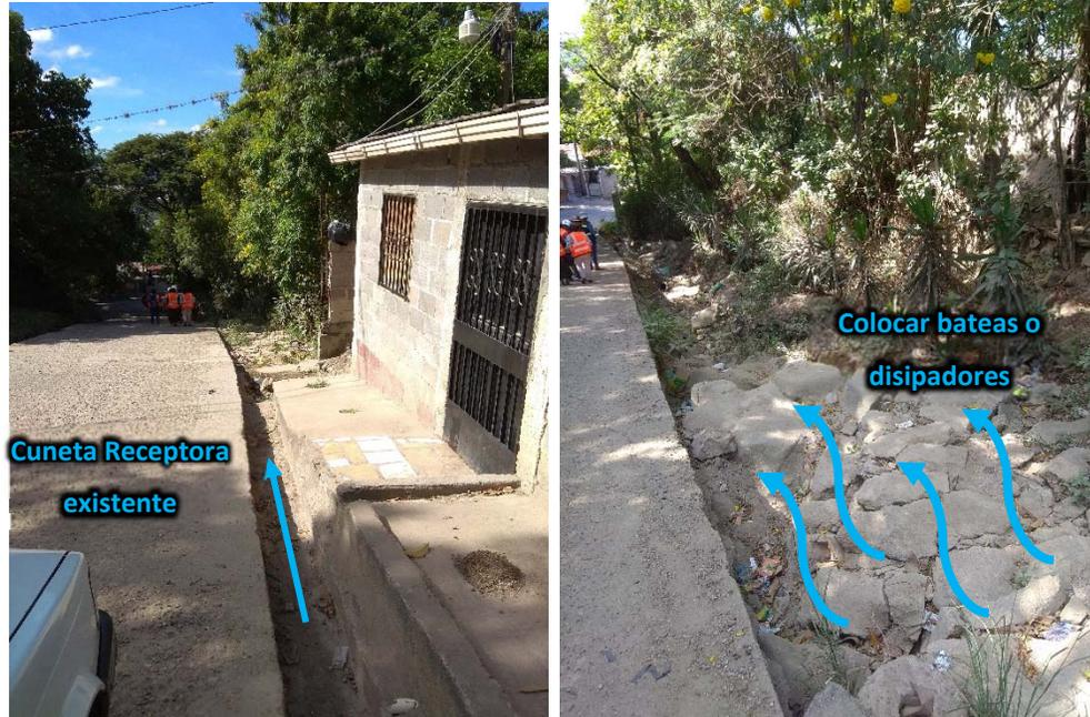
Fotografía 2 – Cuneta receptora existente
