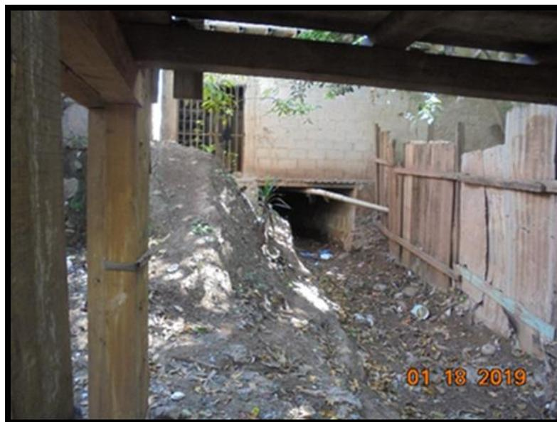
*Ilustración 2 Estrangulamiento del cauce de la quebrada por los pobladores de la zona.*
