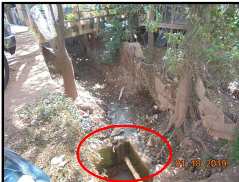
*Ilustración 4 Acceso del flujo del cauce a obra de paso existente por debajo de la calle principal de la Colonia.*
