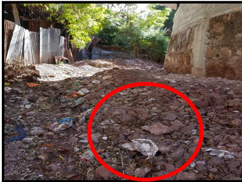
*Ilustración 5 Azolvamiento del lecho de la quebrada producto de desperdicios arrojados por pobladores de los márgenes.*
