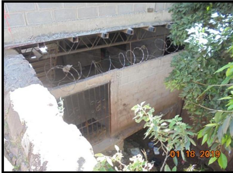
*Ilustración 1 Edificación sobre cauce de quebrada que obstaculiza el flujo natural de la misma.*
