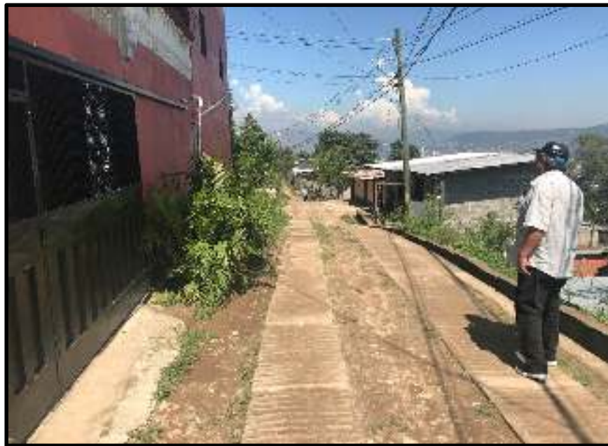
Ilustración 7 Calle con huellas y cuneta existentes al que se conectara cuneta propuesta
