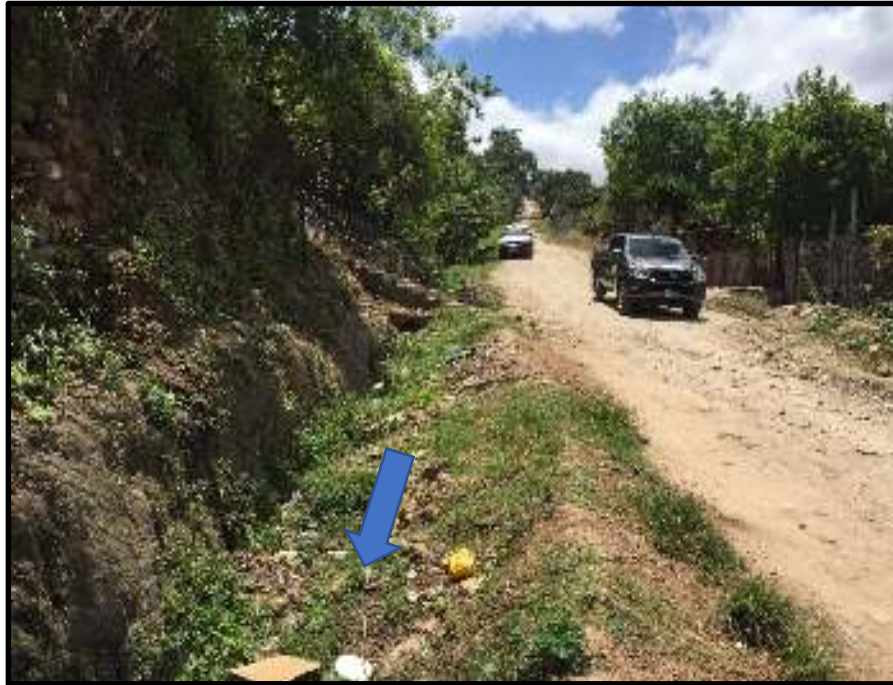
Ilustración 4 Situación del drenaje existente
