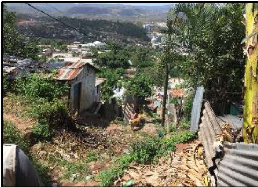
Ilustración 3 Situación actual del drenaje y vías de acceso de los callejones tramo K-L
