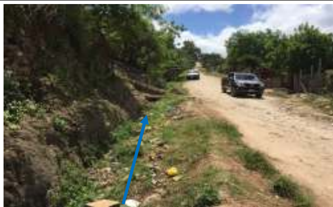
Ilustración 2. Tramo donde se construirá cuneta de 40 cm x 50 cm, al fondo se observa calzada con huella.
