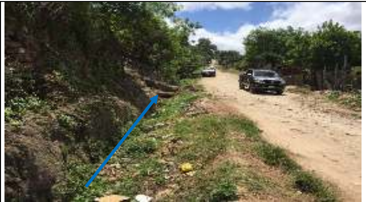
Ilustración 2. Tramo donde se construirá cuneta de 40 cm x 50 cm, al fondo se observa calzada con huella.
