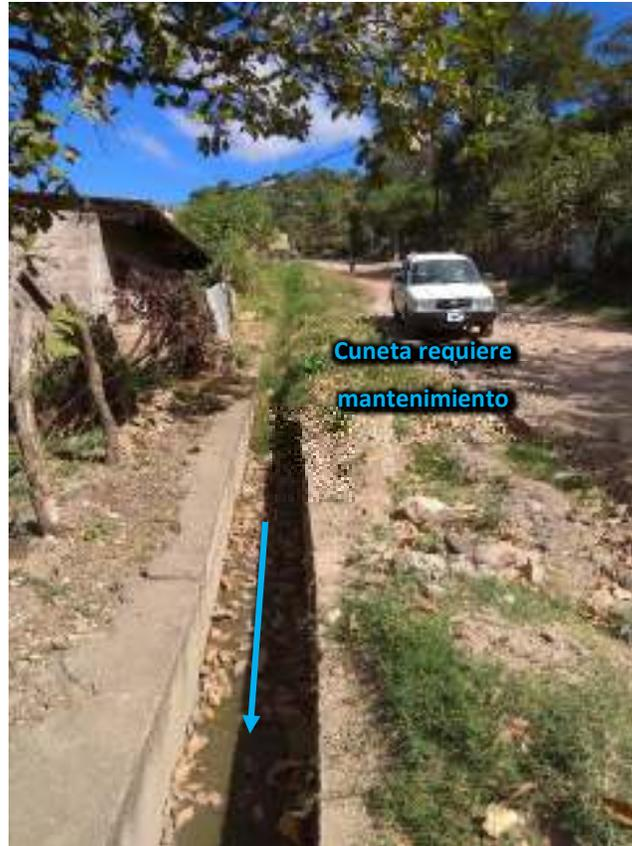
Fotografía 1 - Cuneta receptora (limpieza y readecuación)
