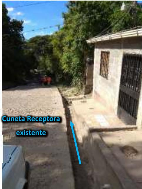
Fotografía 2 – Cuneta receptora existente
