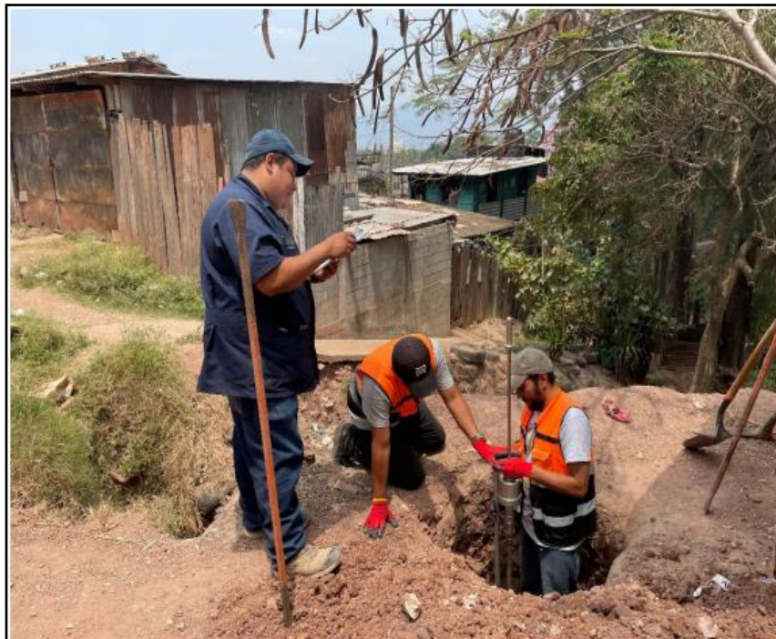
Figura 14: Realización de Calicata/DCP
