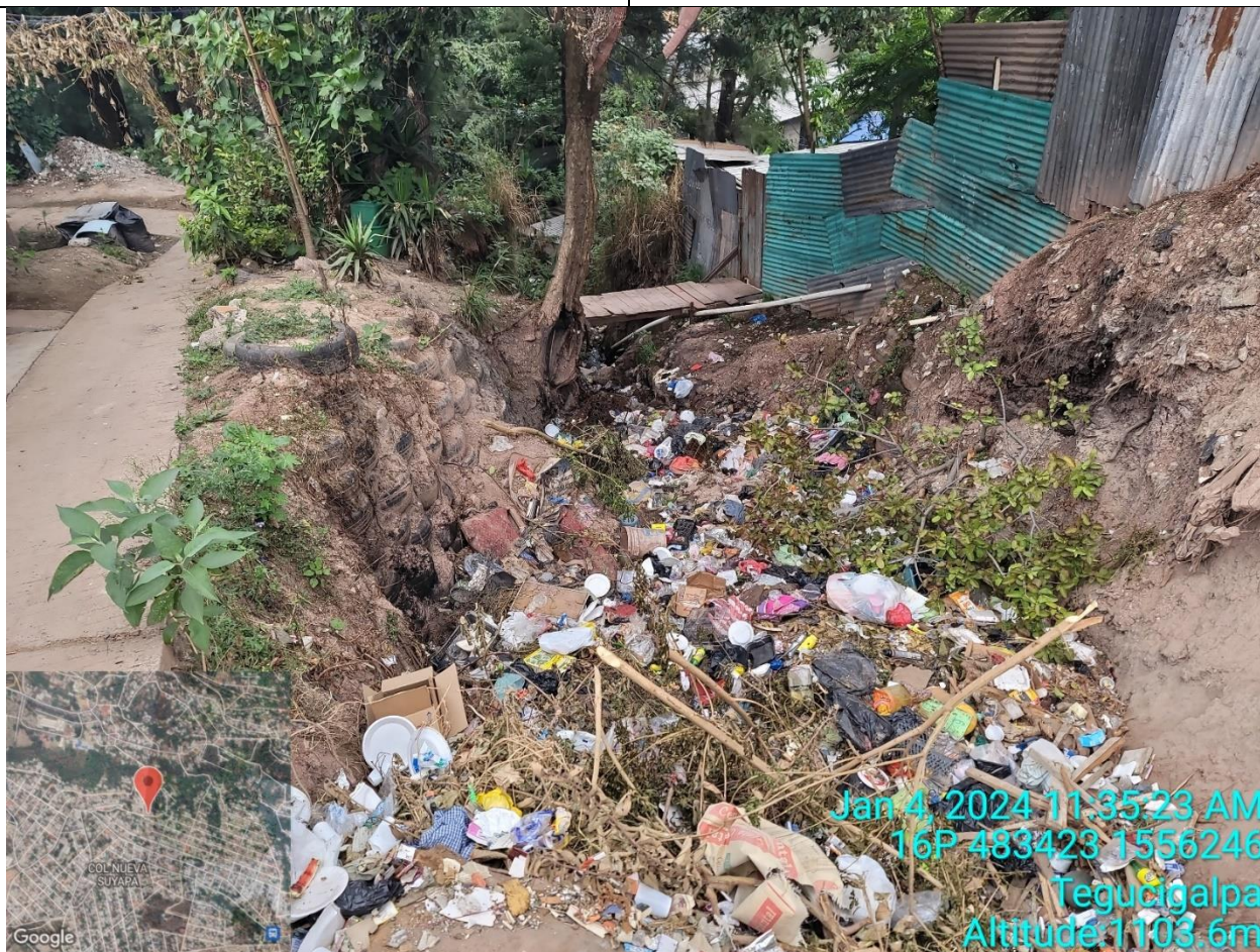
Fotografía 3: Descarga de corredero natural y área prevista para la construcción de parque.
