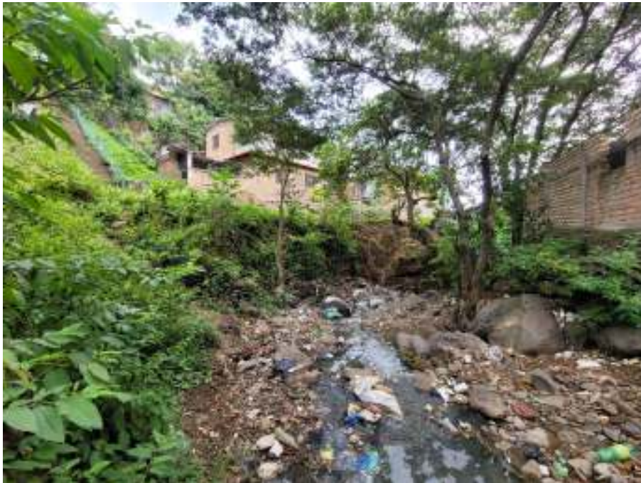
Ilustración 3 Segmento de "Tramo 2" col. Altos del Paraíso, nótese calle próxima al cauce en el margen izquierdo y construcciones en el margen derecho.
