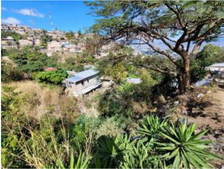
Ilustración 4 Segmento identificado como "Tramo 1", nótese viviendas cercanas.
