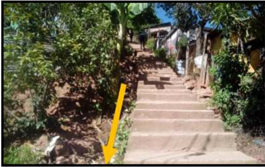
*Ilustración 2 Callejón de gradas cercanas al sitio del proyecto, que no poseen drenajes laterales de tal manera que el agua corre sin control en época lluviosa, tramo de cuneta nodo B-E (ver plano planta-conjunto)*
