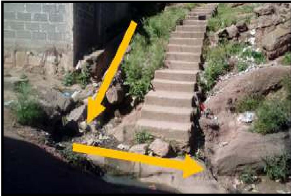
*Ilustración 4 Cunetas existentes en mal estado, tramo a reconstruir nodo A-C (ver plano planta-conjunto)*
