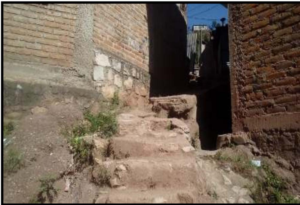
*Ilustración 5 Fotografía que muestra el mal estado de los accesos a las viviendas. Estas áreas de paso y tránsito peatonal pueden rehabilitarse para que funcionen además como rutas de evacuación.*
