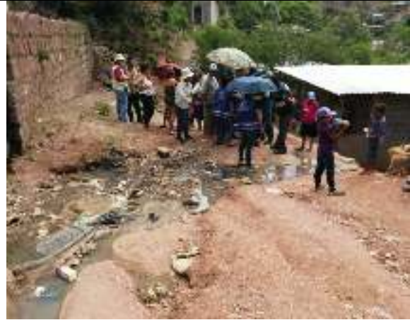
Ilustración 2. Se visualiza la falta de cunetas en las calles de la colonia
