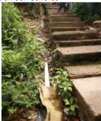
Ilustración 3. Tubería de agua potable descubierta y ubicada en el area donde se preve la construccion de cunetas
