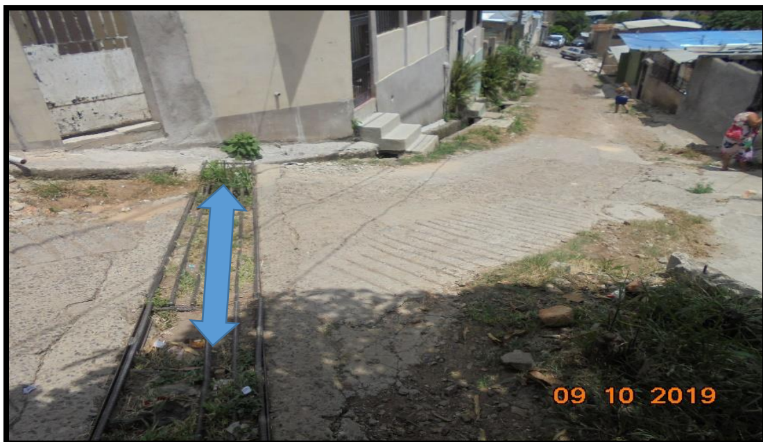
Ilustración 4. Cuneta diagonal en la cuarta calle donde se hará la limpieza de la misma y sustitución de rejilla por vigas tipo quiebrapatas.
