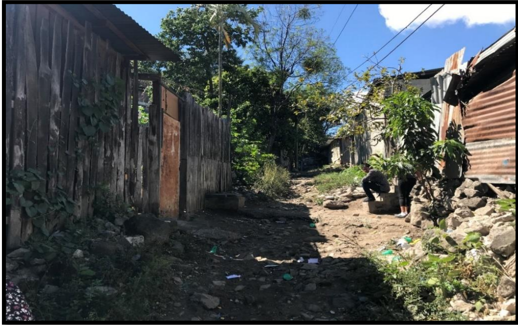
Ilustración 2. Vista de la situación actual de las viviendas donde se construirán cunetas de 30x30 cm.
