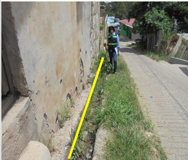
*Ilustración 2. Cuneta diagonal, ubicada en la cuarta calle, en la que se hará limpieza y sustitución de rejilla por vigas tipo quebrapatas.*
