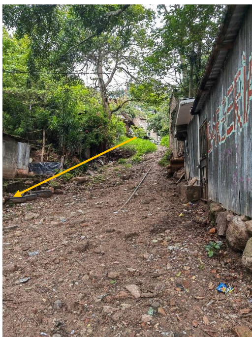
Imagen 7. Sitio de construcción de cuneta y pasos peatonales de acceso a las viviendas
