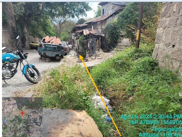
Imagen 1. Cuneta existente a ser reconstruida
