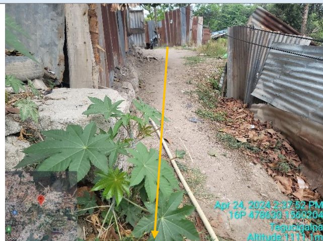
Imagen 2. Área de construcción de cuneta con rejilla, tubería de agua potable a ser reubicada y protegida
