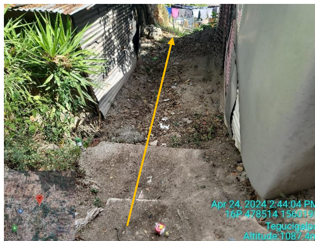
Imagen 4. Área de construcción de gradas con cuneta integrada
