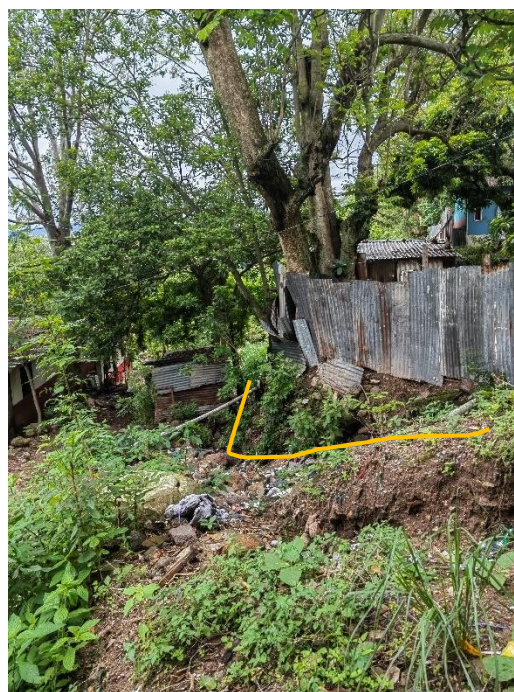
Imagen 8. Sitio de construcción de cuneta
