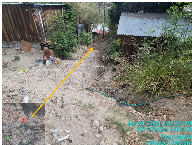
Imagen 3. Sitio de construcción gradas con cuneta integrada
