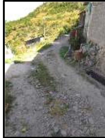
Ilustración 4. Tramo a pavimentar
