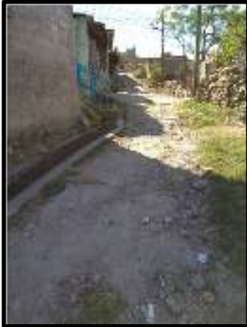
Ilustración 3. Dirección del flujo y al fondo se observan las viviendas afectadas.
