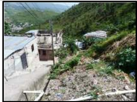
Ilustración 6. Condición actual de la zona y viviendas afectadas de parte baja.
