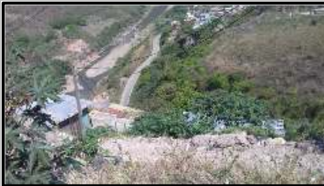
Ilustración 5. Sitio donde se construirá una cuneta
