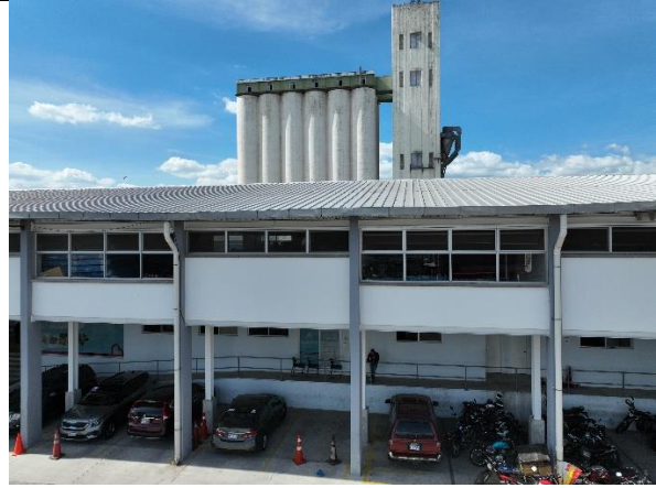
Ilustración 9: Descarga de drenaje hacia el estacionamiento.
