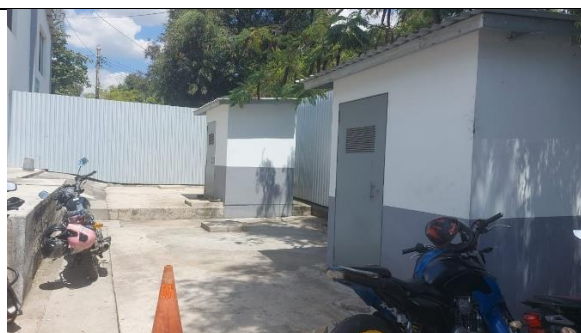
Ilustración 5: Cuartos de bombas.
