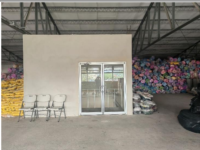
Se observa cubo de gradas internas que conectan con el primer nivel del edificio
