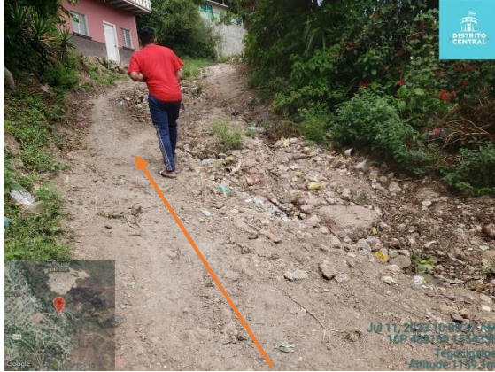
Imagen 5. Sitio construcción de Huellas Vehiculares y cuneta
