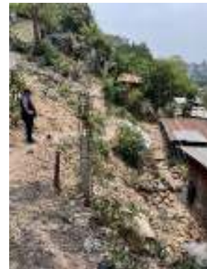
Figura Base de talud donde se proyecta muro de contención.
