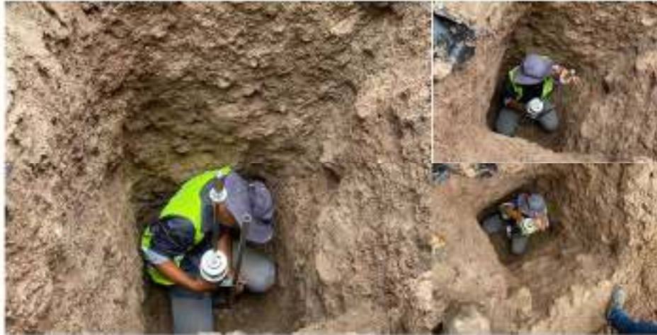
Figura 13 Realizando los trabajos de DCP-1
