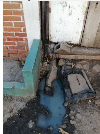
Ilustración 4. Residuos solidos presentes en el area de conexión del desfogue de las cunetas
