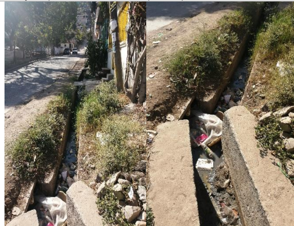
Ilustración 2. Se visualiza la falta de cunetas en el callejón (tramo C-D en el plano)
