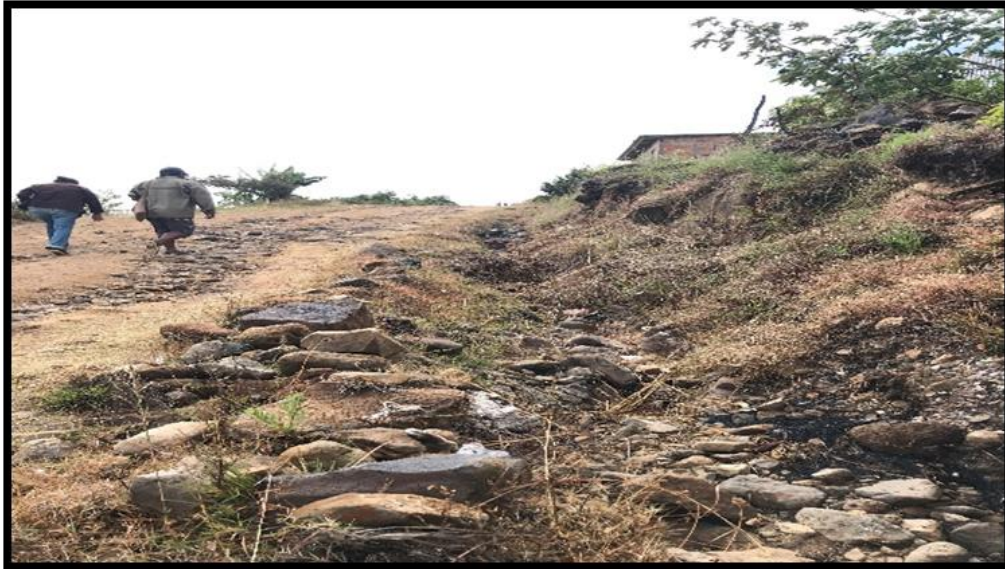
Ilustración 2. Se puede observar la fuerte pendiente y la cantidad y el tipo del arrastre. El proyecto pretende posicionar en este lado de la calle, la medida de mitigación propuesta. (cunetas)
