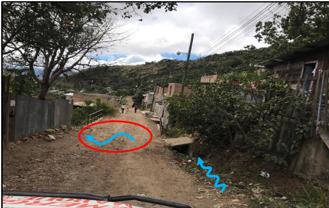
Ilustración 3. Lugar donde serán depositadas las aguas canalizadas del tramo 3. Bajo la caja puente existente.
