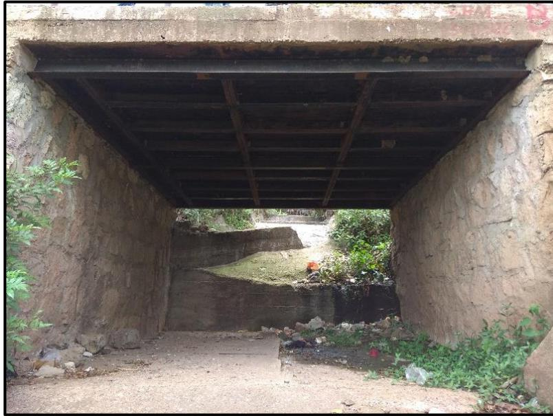
*Ilustración 17: Caja Punte Receptora del Flujo Drenado. (Fuente: Alberto Pinto)*
