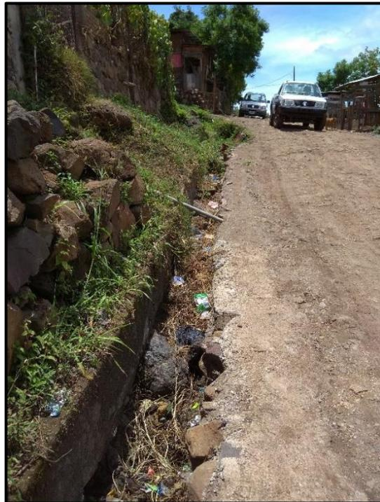
*Ilustración 13: Cunetas Existentes de 1.00mx1.10m*
