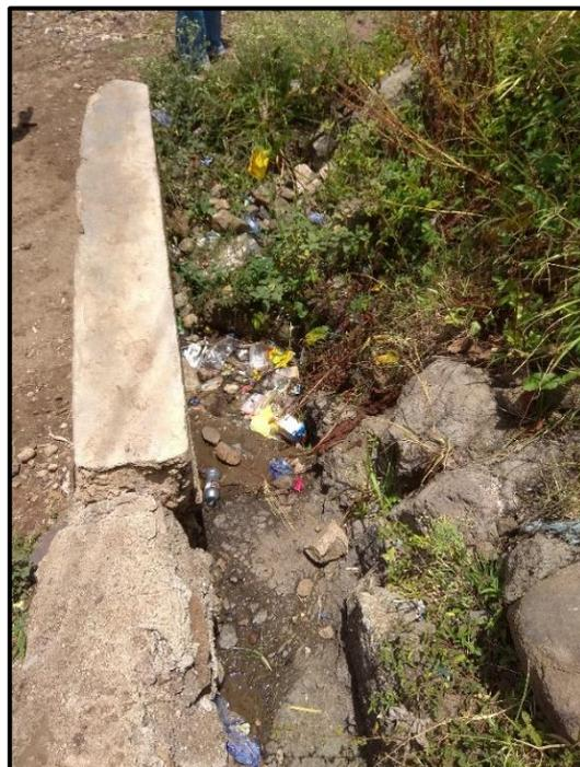
*Ilustración 14: Cunetas Existentes de 0.40m x 0.40m*
