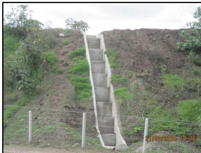
*Ilustración 11: Disipadores de Energía tipo 'Escalonado' (Fuente: Google)*
