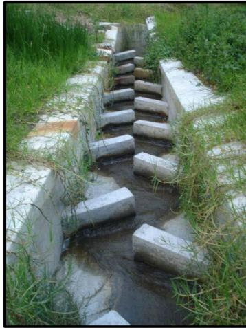
*Ilustración 10: Disipador de Energía Tipo 'Canal con Pantallas Deflectoras' (Fuente: Google)*
