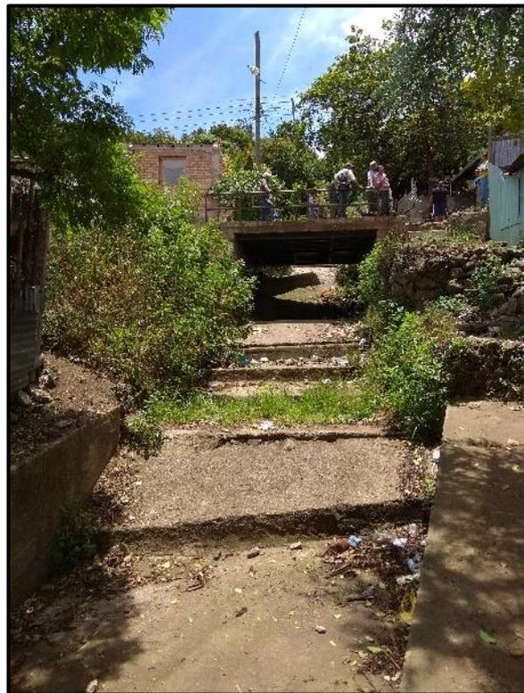
*Ilustración 16: Caja Puente Receptora del Flujo Drenado. (Fuente: Alberto Pinto)*
