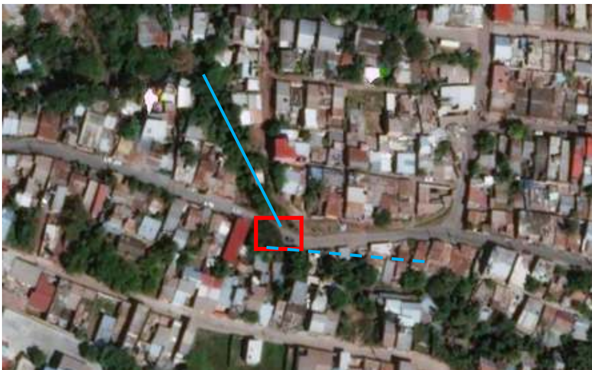
Figura 1: situación de la quebrada y zona de inundación
