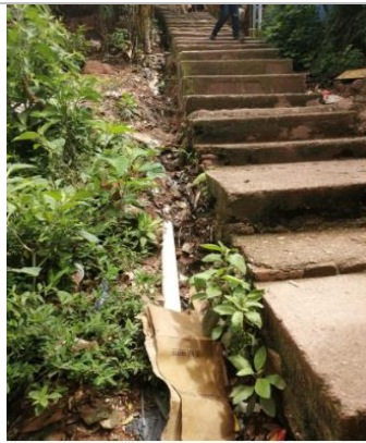
Ilustración 3. Tuberia de agua potable descubierta y ubicada en el area donde se preve la construccion de cunetas
