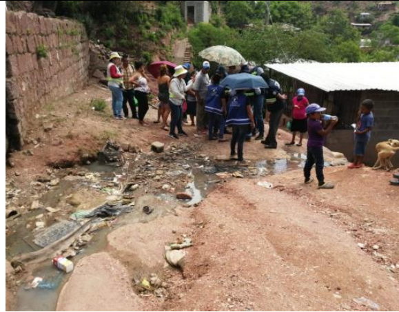
Ilustración 2. Se visualiza la falta de cunetas en las calles de la colonia
