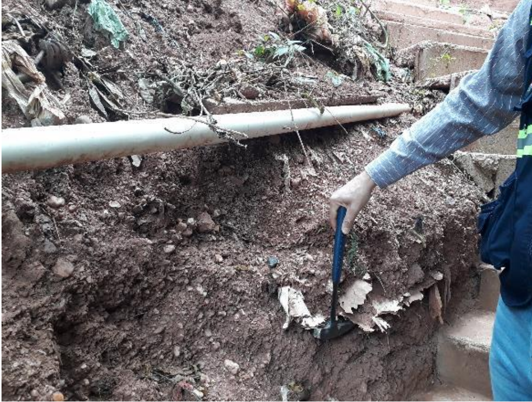
Figua2: extensión y espesor de los materiales procedentes de excavaciones
