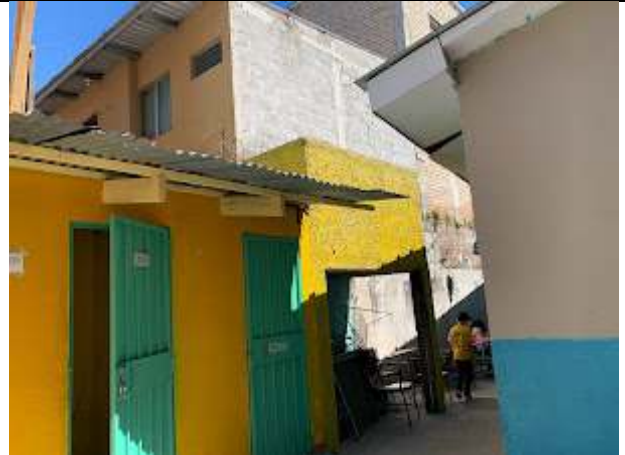
Ilustración 5: Modulo de sanitarios existente.
