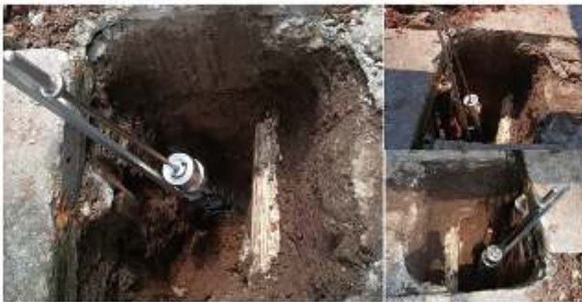
Figura 7: Ensayos de DCP calicata 1
