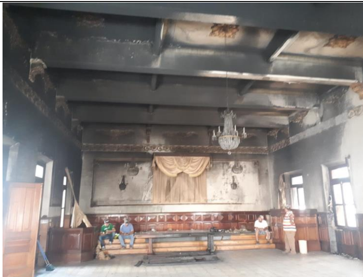
No. 2 VISTA DEL SEGUNDO NIVEL EN EL SALÓN DE CABILDOS DONDE SE REALIZARÁN ACTIVIDADES DE LIMPIEZA DE CIELOS Y PAREDES.
