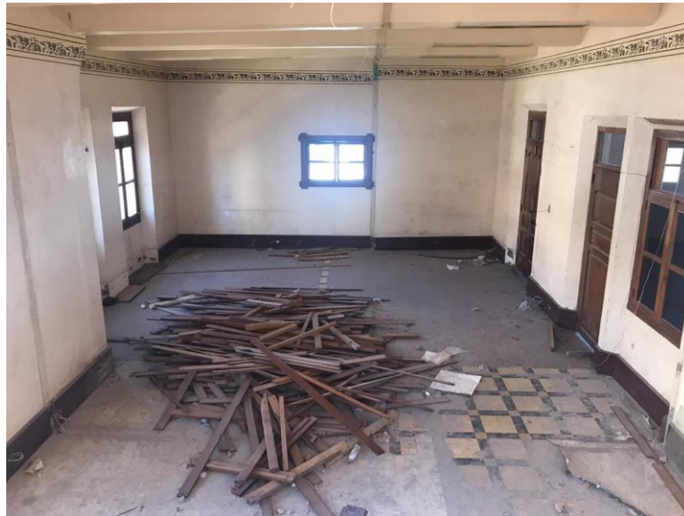
No. 4 VISTA DE TERCER NIVEL, LUGARES DONDE SE COLOCARÁN AIRES ACONDICIONADOS.
