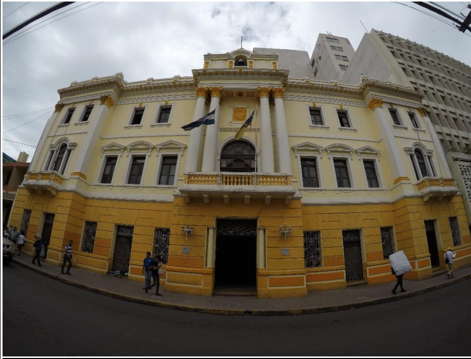
No. 1 VISTA DE LA FACHADA ACTUAL DEL INMUEBLE.
