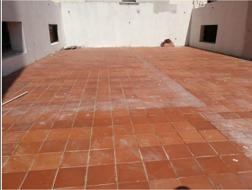
No. 5 | IMAGEN DE LA AZOTEA 1 DONDE ACTUALMENTE HAY UN PISO DE LOSETA DE BARRO.
