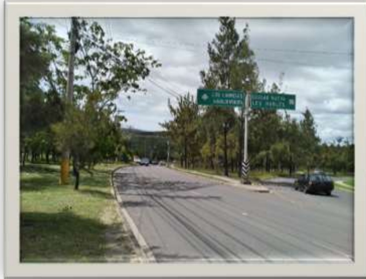
En la imagen se muestra el Anillo Periférico a la altura del desvío hacia la calle Los Alcaldes
