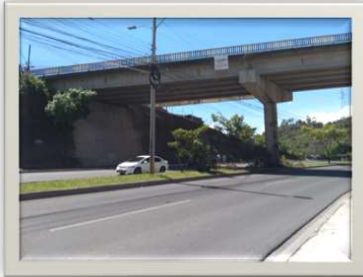
En la imagen se muestra la estructura del puente actual en el Anillo Periférico a la altura de Las Casitas
