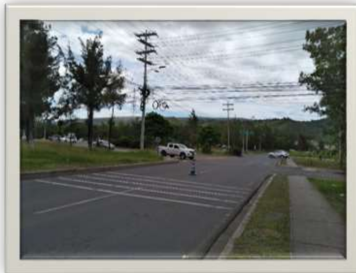
En la imagen se muestra el Anillo Periférico a la altura del desvío a Mateo
