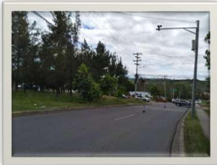
En la imagen se muestra el Anillo Periférico a la altura del desvío a Mateo y salida de calle Los Alcaldes
