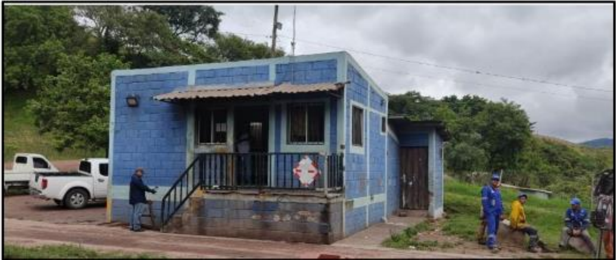
Vista Oeste del edificio de oficinas y bodegas en Báscula del Relleno Sanitario
