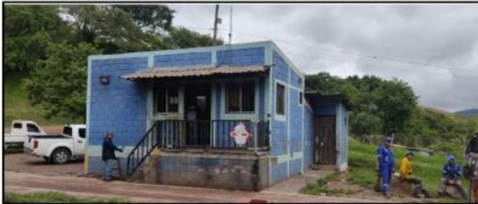
Vista Oeste del edificio de oficinas y bodegas en Báscula del Relleno Sanitario
