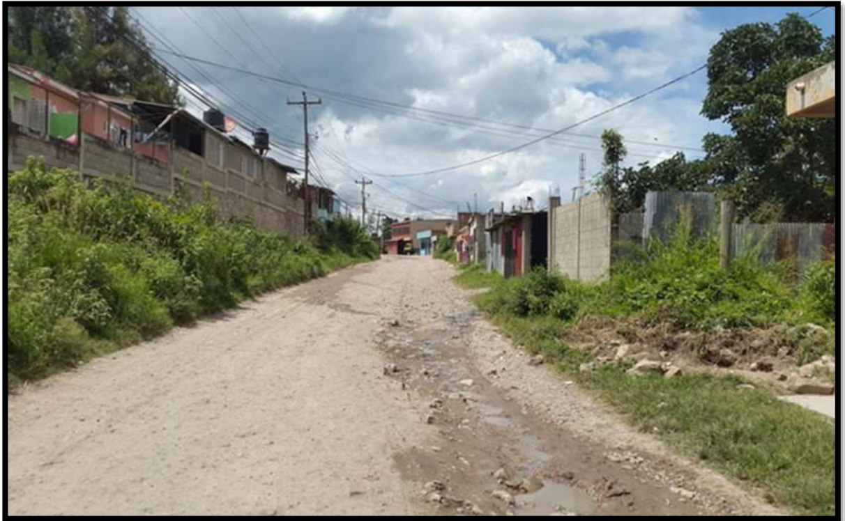
Tramo Lomas del Sur – Colonia Reynel Fúnez, Zona #1.
