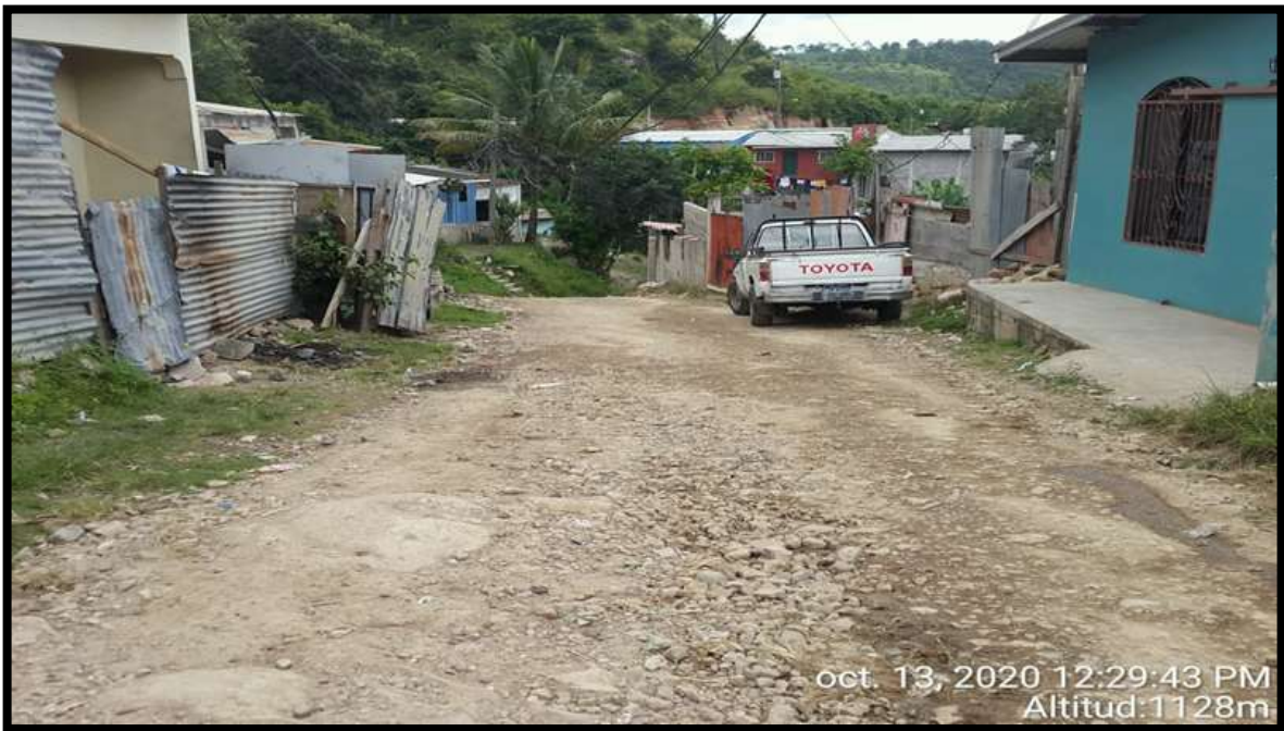
Tramo de zona #2 y #3 Colonia Reynel Fúnez
