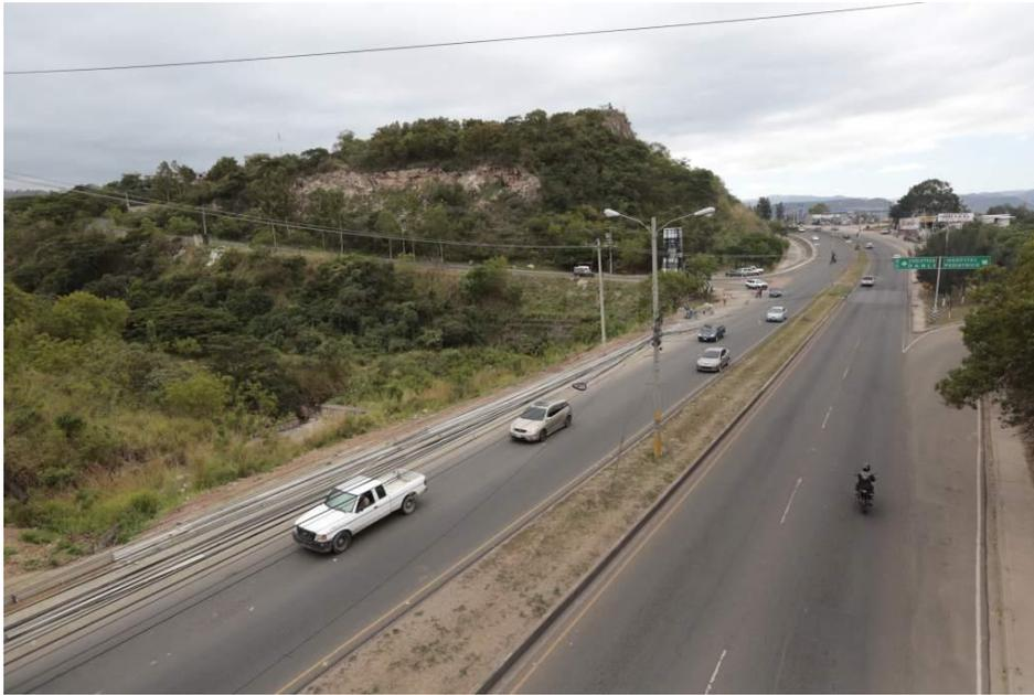
En la imagen se muestra una sección a la altura de altos del trapiche, donde se realizará el mejoramiento de la calzada existente con la colocación de una carpeta asfáltica de 3cm y la ampliación del tercer carril con concreto hidráulico.
