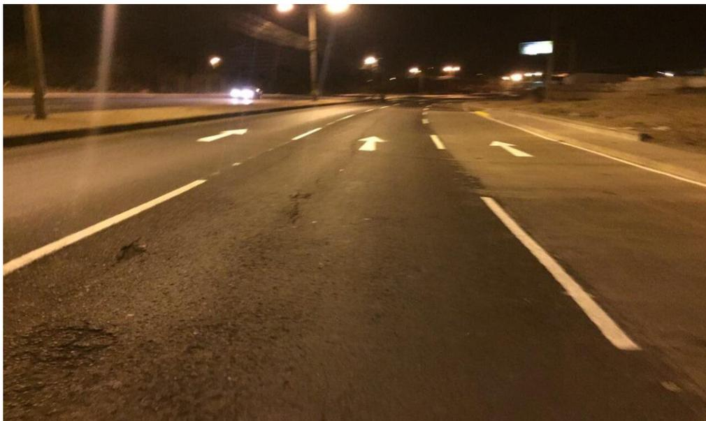
En la imagen se muestra un tramo donde ya existe el tercer carril construido con concreto hidráulico, por lo que solo será necesaria la rehabilitación de los carriles de concreto asfáltico existente, **para garantizar que la transición entre los carriles de asfalto y concreto hidráulico sea por el mismo nivel de rasante**, será necesario realizar el fresado en el asfalto para así colocar la nueva carpeta asfáltica de 3cm.
