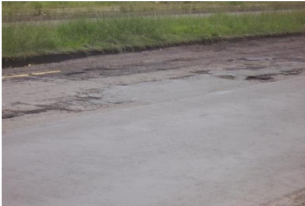
En las imágenes se muestra el desgaste en la superficie producto del tráfico permanente y la saturación de la calzada durante la época lluviosa en el Distrito Central.
