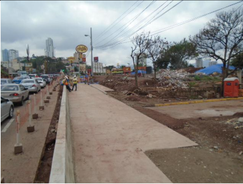
N°75 Vista sobre calle en construcción paralela a bulevar Juan Pablo II, terreno a la par de quebrada.
