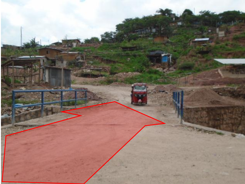
N°33 Vista sobre calle 1, hacia puente en calle 2.
