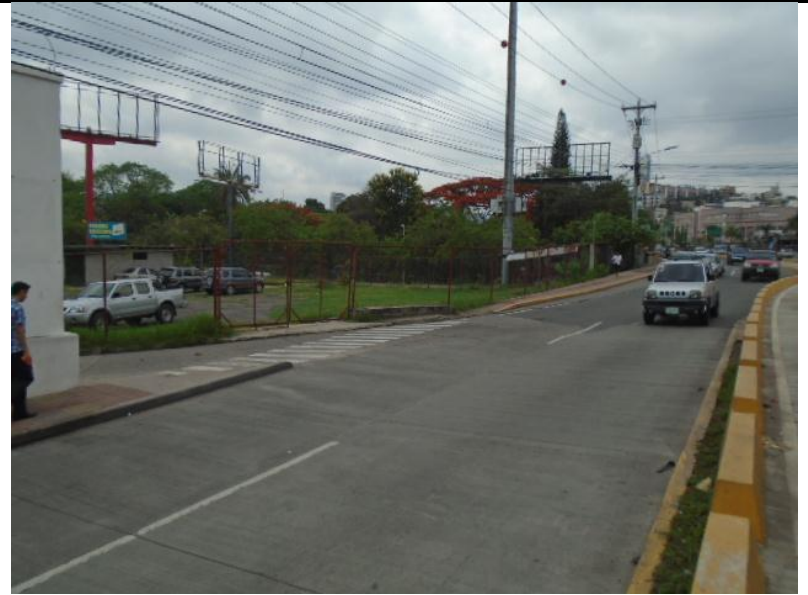
N°94 Vista de retorno de Blvd. Suyapa hacia Blvd. Juan Pablo II. Viniendo de Blvd. Suyapa.
