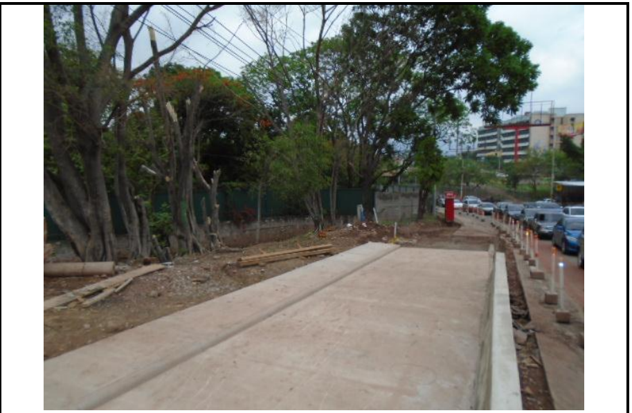
N°74 Vista sobre calle en construcción paralela a bulevar Juan Pablo II, terreno a la par de quebrada.
