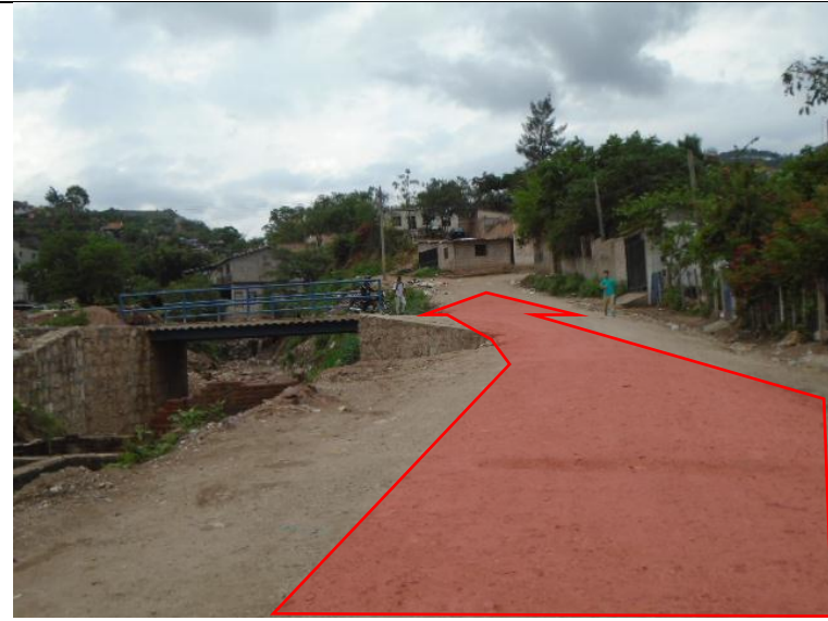
N°32 Vista sobre calle 1, hacia puente de calle 2.
